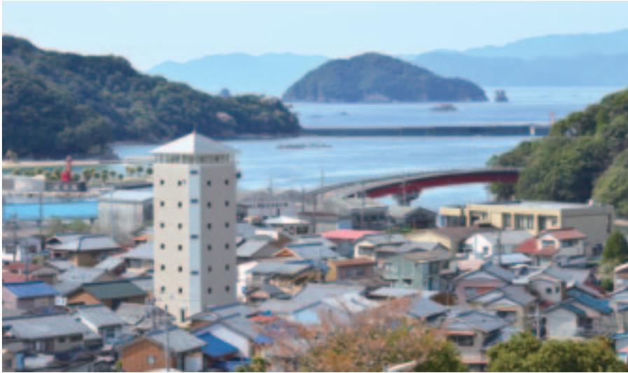
この『第2錦タワー』の建設場所は、魚市場の近くに位置し、津波が最も早く到達する地区であり、山裾の高台にある津波避難所へは遠く、大地震により民家等が倒壊し避難路が寸断された場合に、市場で働く方や住民の皆さんが迅速に避難できるように建設しました。構造は鉄筋コンクリート造一部鉄骨造8階建てで、1階が3ヶ所の入口と消防用倉庫、2階が台風、大雨警報発令時などの避難室、6階、7階が津波時の避難
