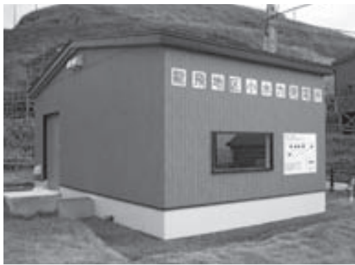
△龍飛地区小水力発電所
