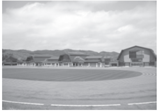
◁東通小学校全景
