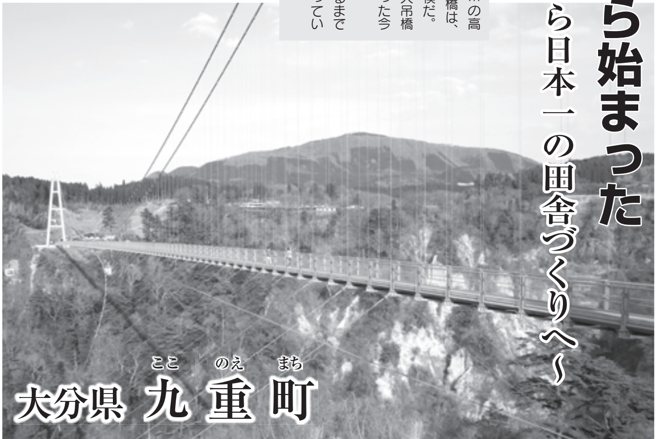
△九重「夢」大吊橋は、直径53mmのワイヤーを7本束ねたメインワイヤーで吊られている。65kgの大人が約1800人乗っても耐えられる設計だ
