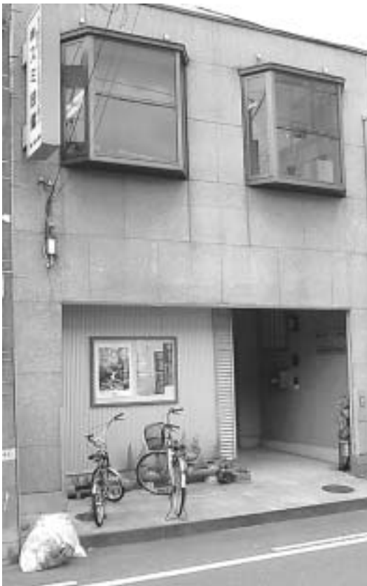
スミ設備の社屋の一部に設置した名古屋出張所
