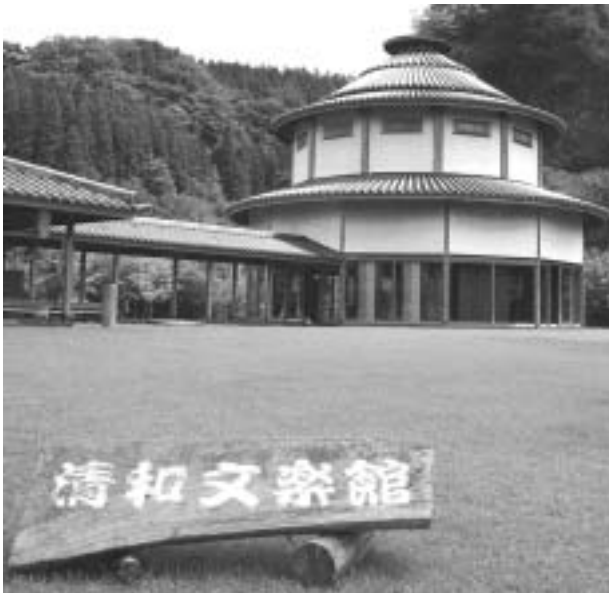
平成4年に完成した、清和文楽館
