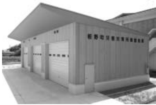
板野町災害対策用備蓄倉庫
