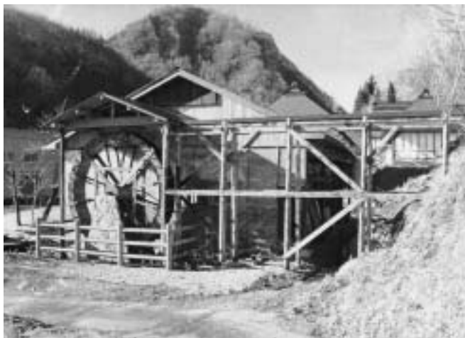
水車の動力でろくろを回し木地を挽く
