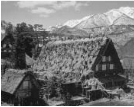
合掌造りの屋根葺き替え (白川村荻町)
