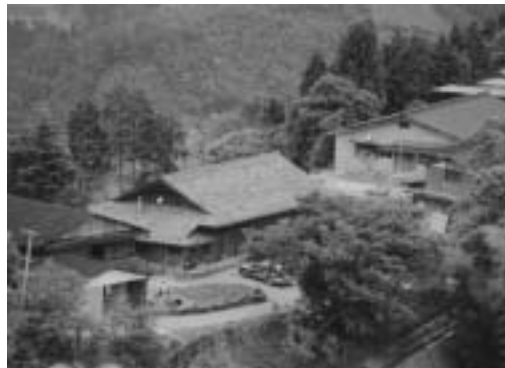
山中の古民家を改修した交流拠点
