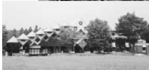
駅跡地に建てられた「ゆうステーション」(交通センター)
