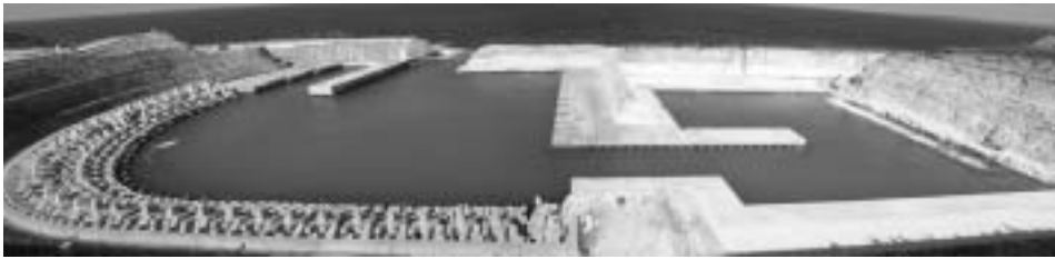
島を掘り込んだ工法で建設中の漁港
