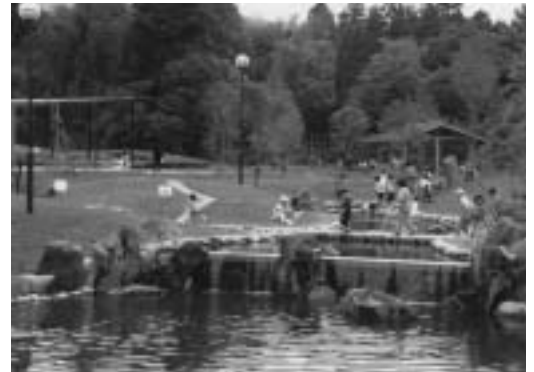
完成した「矢護川公園」
