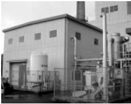
ごみ焼却プラント
