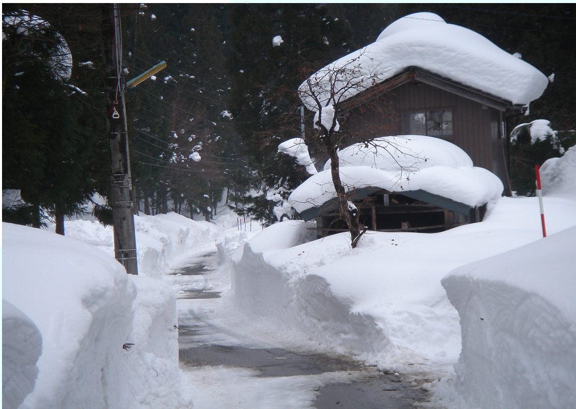
富山県上市町 屋根雪の重みで傾いた小屋。
