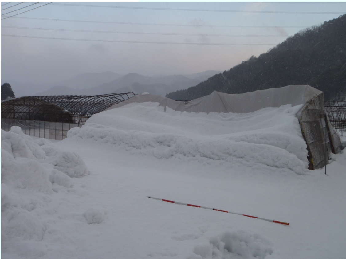
福井県高浜町 ビニールハウス（40m×8m）の倒壊。
