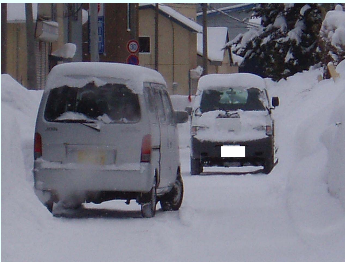
青森県平内町 雪により道幅が狭くなり、すれ違いが困難。
