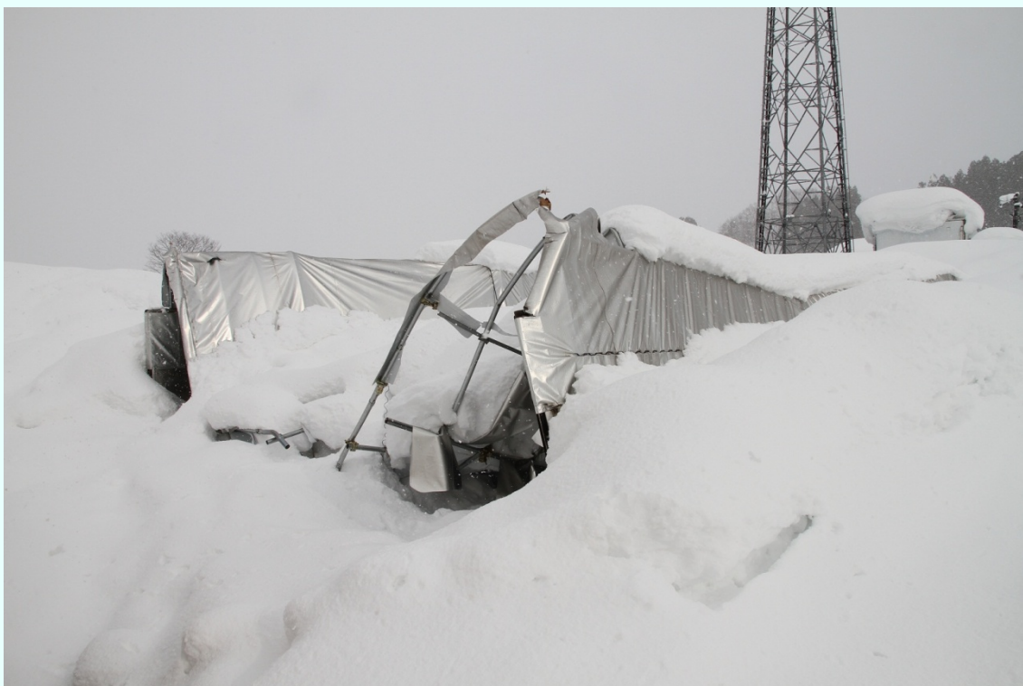
新潟県津南町 きのこのパイプハウスが雪の重みのため倒壊。
