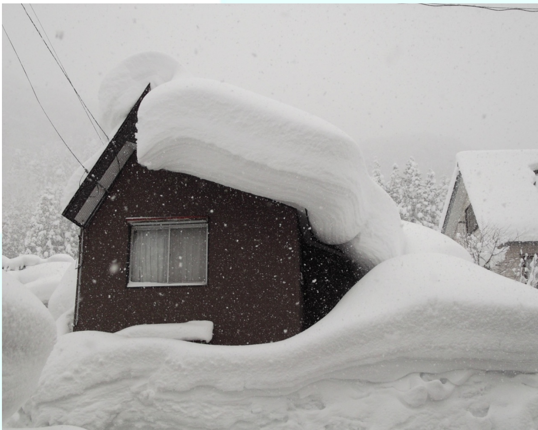
新潟県湯沢町 雪下ろしのスペースにも苦慮するほど積もった屋根雪。
