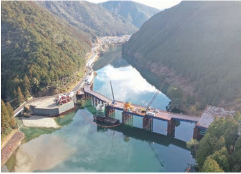
▲奥澗道路Ⅲ期区間工事
