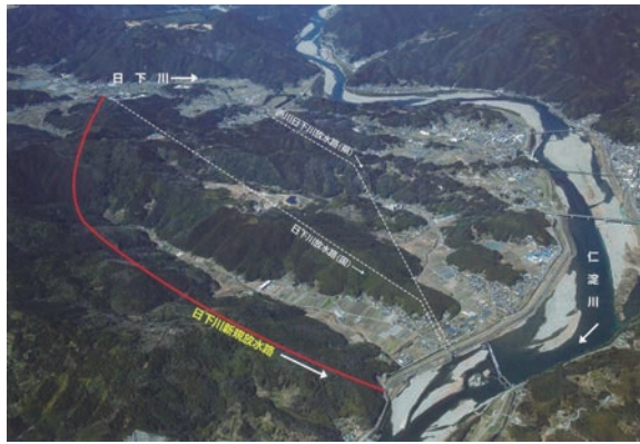
▲放水路吐口(仁淀川合流点)より日高村を望む
