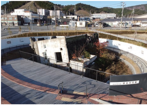
▶東日本大震災の津波の引き波により横倒しになった震災遺構「旧女川交番」。
