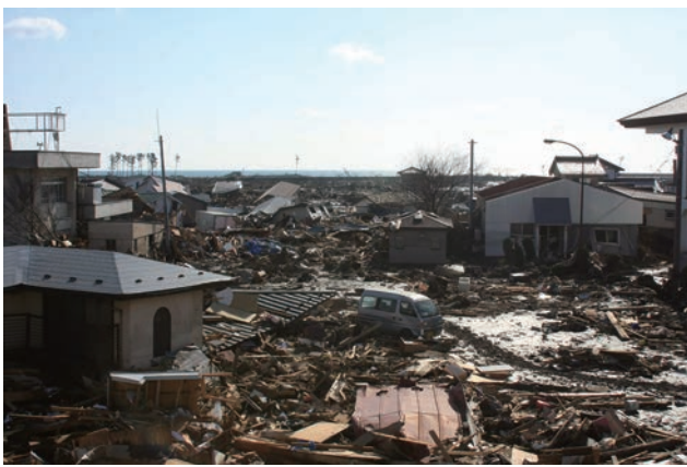
▶津波被災後（平成23年3月12日津波翌日の野田村役場前）
