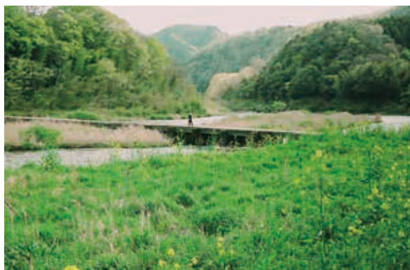
▲木津川を横断している「恋路橋（潜没橋）」
