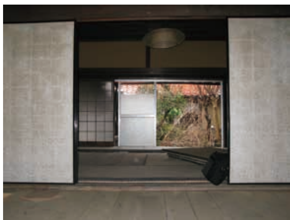
◀町家ステイ戎丁 改修前（右）、改修後（左）
