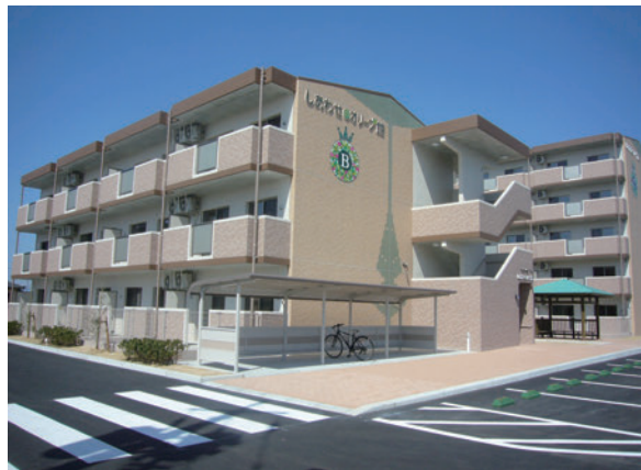
新たに整備したPFI住宅
