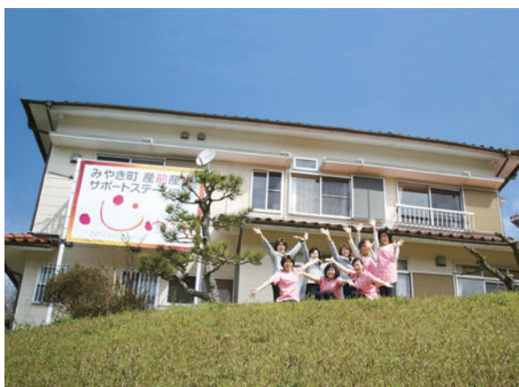
▶産前産後サポートステーション(外観)
