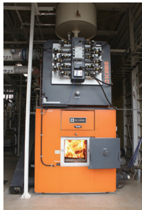
▲木質バイオマスボイラ
