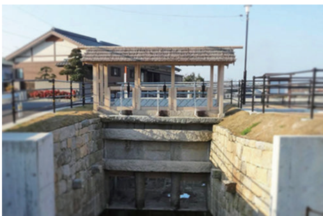
▶移築復元された「土手町南蛭樋」
